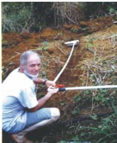
David Hosick pokládá vodovodní potrubí
